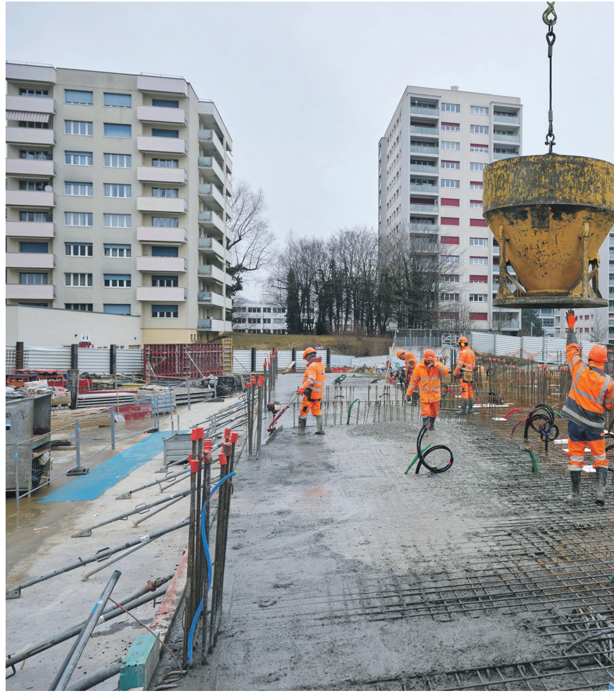
Die Arbeiten am Invictus-Turm Freiburg laufen auf Hochtouren. Das Projekt kostet rund 85 Millionen Franken.
